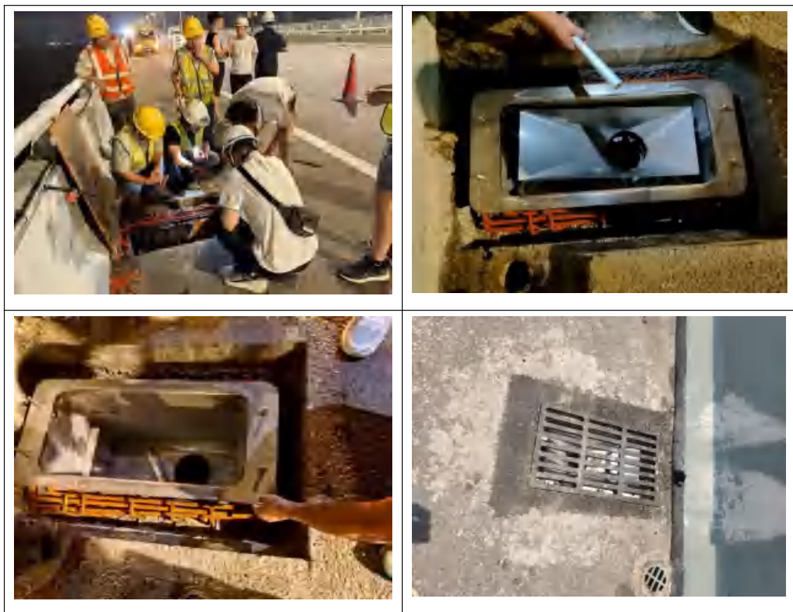
图 12.4-1 杏林大桥桥面环保型雨水口现场照片
